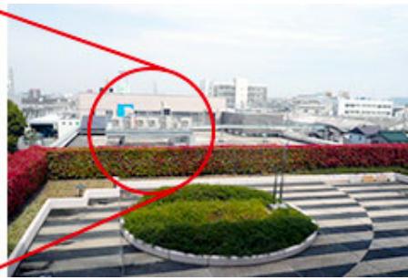
旧研究本館屋上の室外機移設状況
