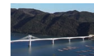
“备前♡日生大桥”（冈山县）
