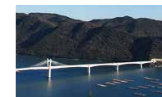
「備前〇日生大橋」(岡山県)
