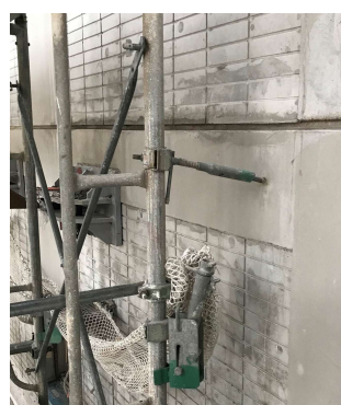
<壁つなぎ施工写真② フラット面>
