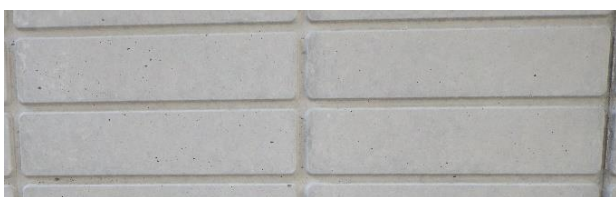
コンクリート躯体と一体化したタイル意匠
