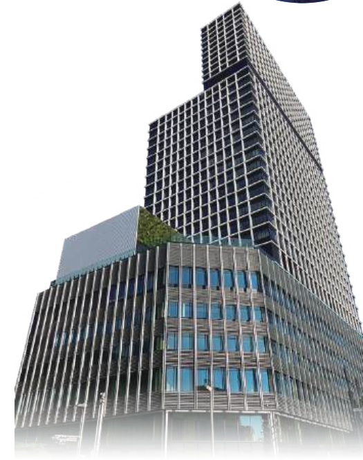
「中日ビル」(愛知県 名古屋市中)など、ビルの安全を支えます
