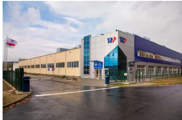
第2工場の外観
