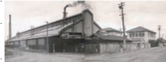
四日市の工場
